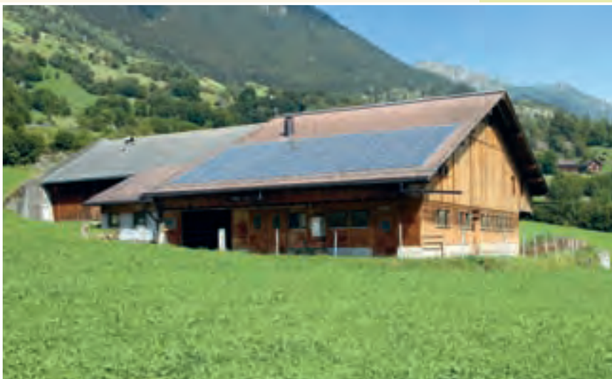
In die Dachfläche integrierte Solaranlage
