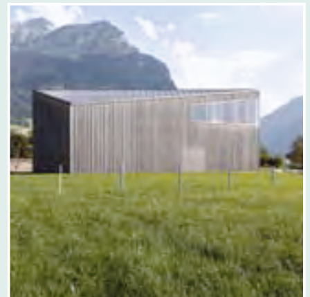
Wasserversorgung Zwyrmatte, Altdorf
