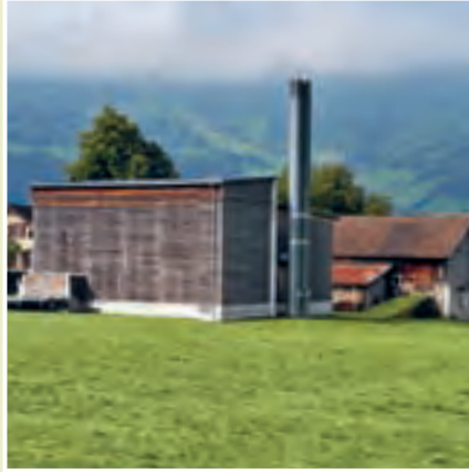
Holzsnitzelheizung Brickermatte, Bürglen
