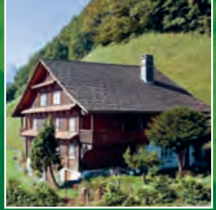
Klebedächer , Wohnhaus Gwand, Seelisberg
