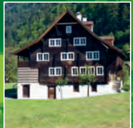
Lauben , Wohnhaus Balmermatten, Bürglen
