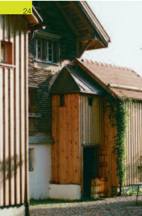
Anbauten mit Holzleistenschirm
