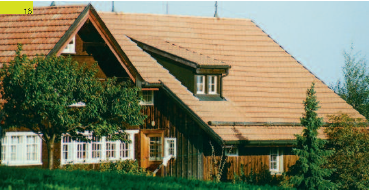
Schleppgaube mit 4-teiligen Fenstern und schlanken Wänden
