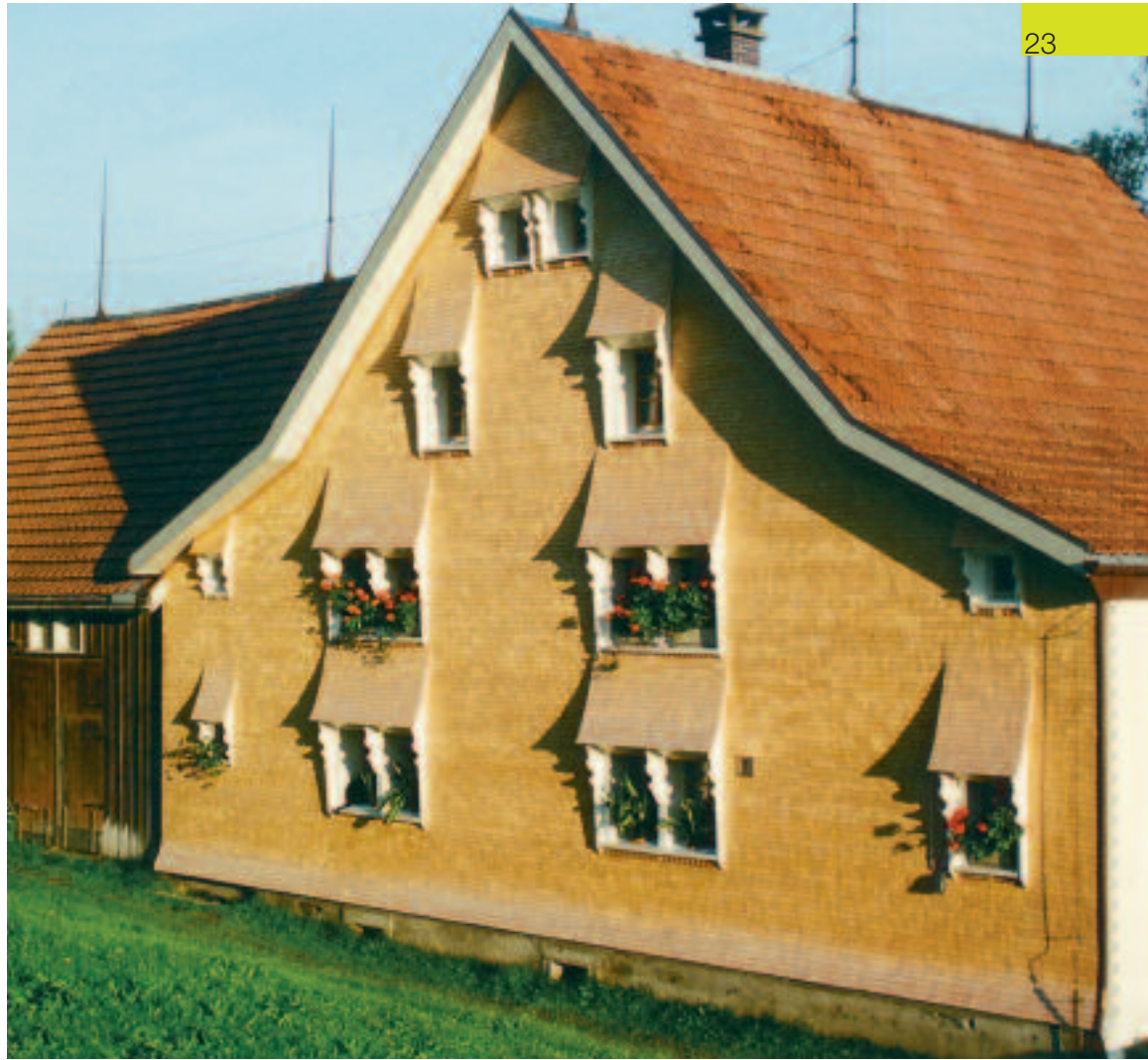
Holzschindelschirm mit verzierten Seitenbrettern und Abwurfdächli bei den Fenstern
