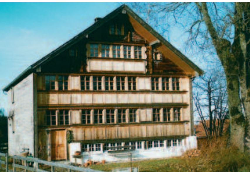
Strickbau mit Holztäfer verkleidet
