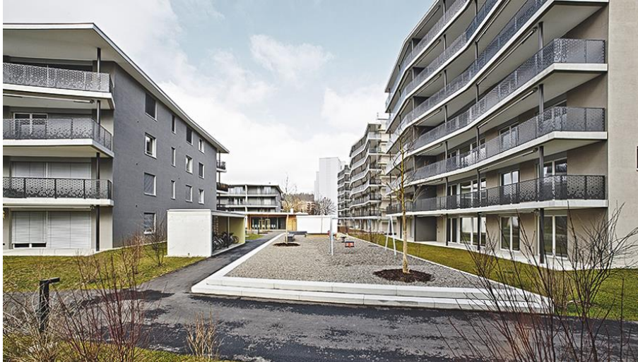
15 Siebengeschossige Lärmschutzmassnahme: Die Liegenschaften an der Habsburgerstrasse in Brugg AG (rechts im Bild) schirmen das ganze Areal vor Eisenbahnlärm ab. Mehr dazu auf www.densipedia.ch . Foto: www.gross-ag.ch
