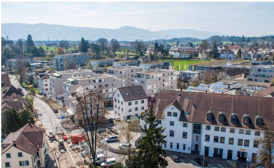
14 Sanfter Übergang zwischen Alt und Neu: In Rüti verhinderte das ISOS das geplante Hochhaus. An dessen Stelle stehen nun zwei moderne Giebelhäuser (Bildmitte). Foto: A. Straumann, EspaceSuisse
