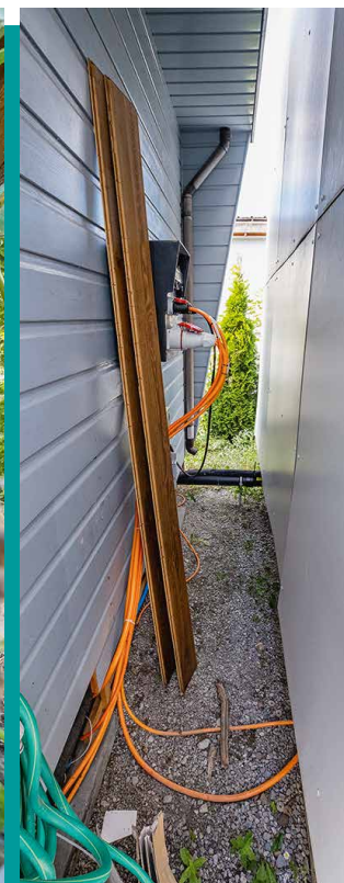
12 | Untersicht sowie Strom- und Wasseranschlüsse einer Fahrnisbaute, Standplatz Bern-Buech, BE
