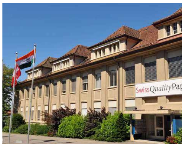
Lo stabile amministrativo della cartiera è menzionato nell'ISOS in quanto elemento eminente. Fonte: balsthal-collector
