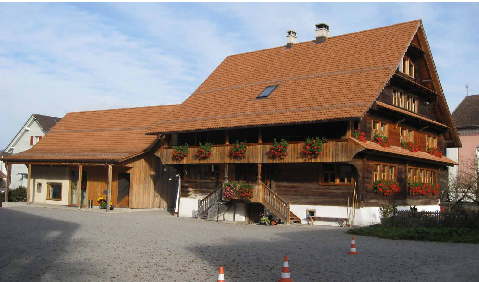
Con la sua fattoria, il suo lavatoio, il suo granaio e la sua corte, il Margrethenhof, situato al centro del villaggio di Ballwil LU, è un indicatore identitario per la popolazione locale (gmt-architekten.ch, stato al 04.09.2017). Foto: Lukas Bühlmann, EspaceSuisse
