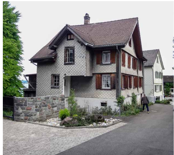
È prevista la demolizione di questo edificio e la sua sostituzione con una nuova costruzione. Foto: Philipp Maurer
