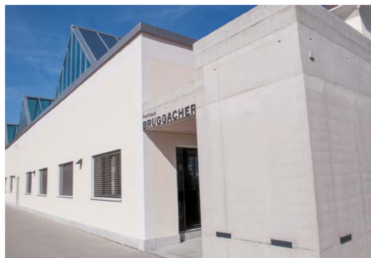
Die einstige Fabrik wurde mit einem Anbau mit Zugang zur farbigen Tiefgarage versehen.
