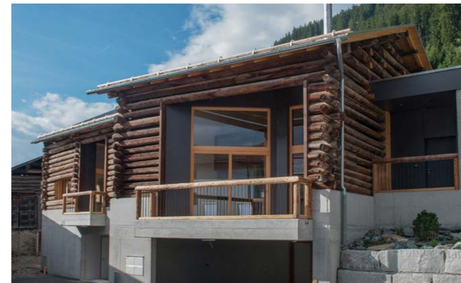
Die ehemaligen Ställe des Bauernhauses bieten heute exklusive, topmoderne Wohnungen (Foto links). Unter anderem ist die Garage mit Steckdosen für Elektro-Autos ausgerüstet. Foto: A. Straumann, VLP-ASPAN
