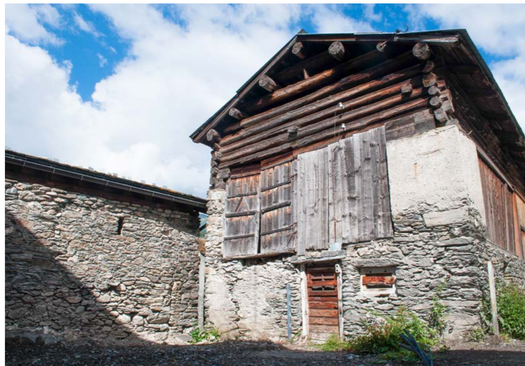
Das nächste Projekt von Investor Kägi? Auch diese ehemalige Stallscheune haben Kägis gekauft. Bereits gibt es Pläne, auch dieses Gebäude in Wohnraum umzubauen. Fotos: A. Straumann, VLP-ASPAN
