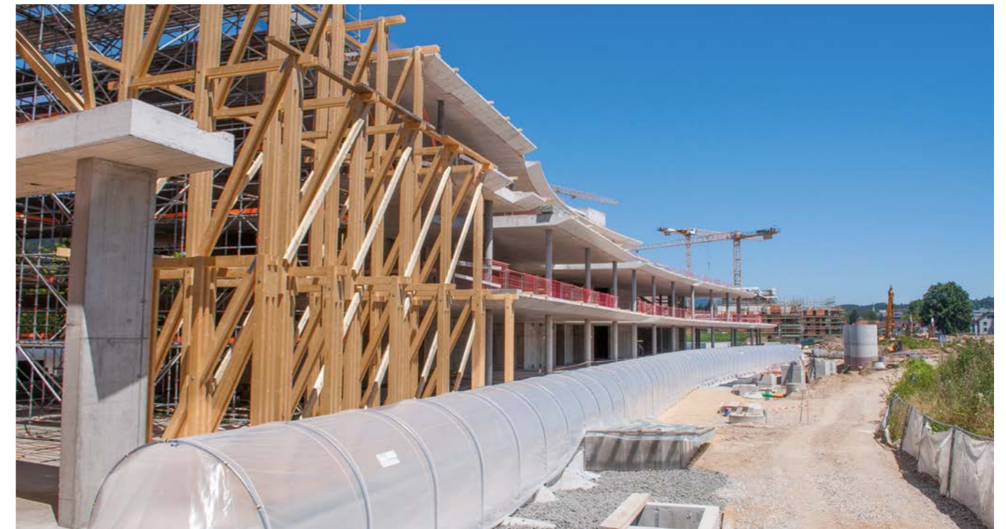
Der Swatch-Neubau besteht aus Tausenden von Holzbalken. Ende Juli (hier im Bild) war das Gerüst schon zu sehen. Fotos: A. Straumann, VLP-ASPAN
