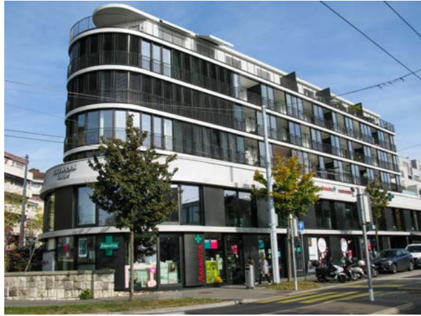
Unsere Städte müssen in die Höhe wachsen. Wie dies zwischen zwei Strassen gehen kann, zeigt dieses Gebäude in Lausanne. Die alte Substanz wurde saniert und es wurde aufgestockt.
