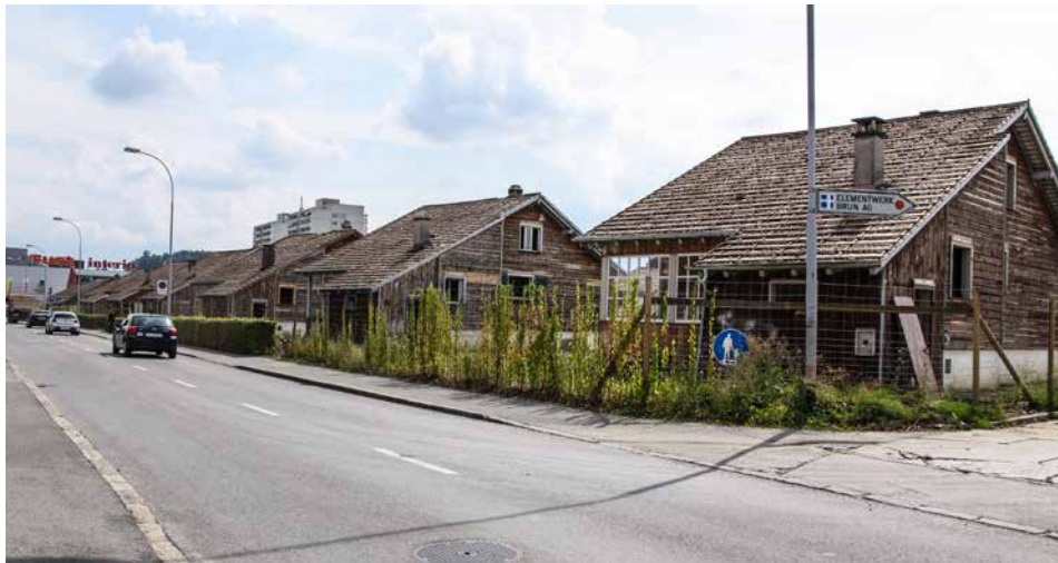
Die alten Arbeiterhäuschen auf der Feldbreite in Emmen – hier bereits ohne Fassadenschindeln – bestanden vorwiegend aus Holz. Zuletzt liessen sich dafür kaum noch Mieter finden. Darum wurden alle 56 Häuschen im Jahr 2012 abgerissen. Fotos: Gemeinde Emmen
