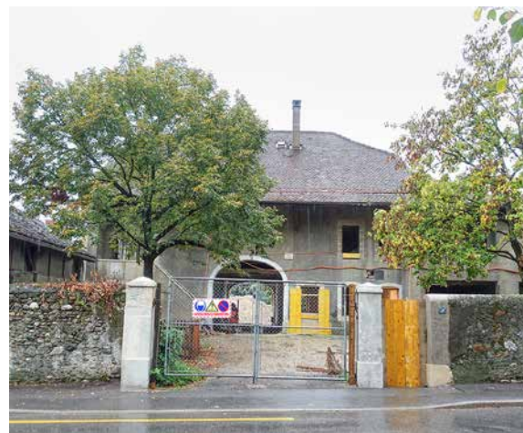
Der ehemalige Bauernhof Menut-Pellet wird umgebaut. Bald entsteht hier das Quartierzentrum.
