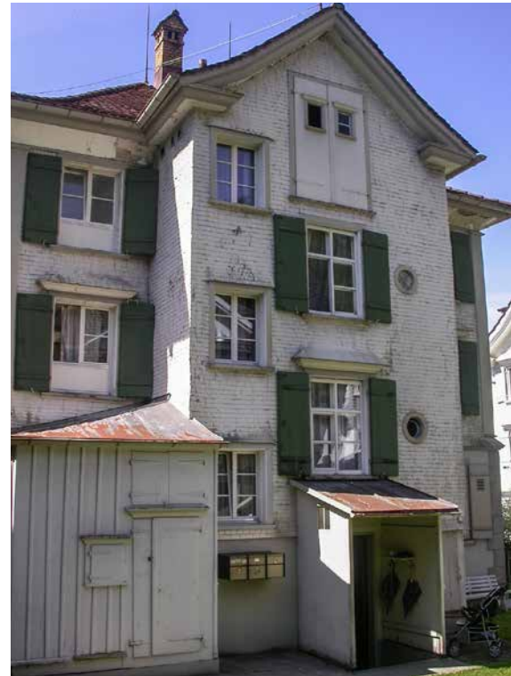
Die kleinen Anbauten wurden entfernt und durch einen Carport mit Terrasse ersetzt. Foto: bm architekten eth sia
