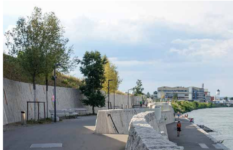
Die Bäume werden im Lauf der Zeit wachsen und grosszügig Schatten spenden. Unter dem Kronendach werden die Mauern kleiner wirken.
