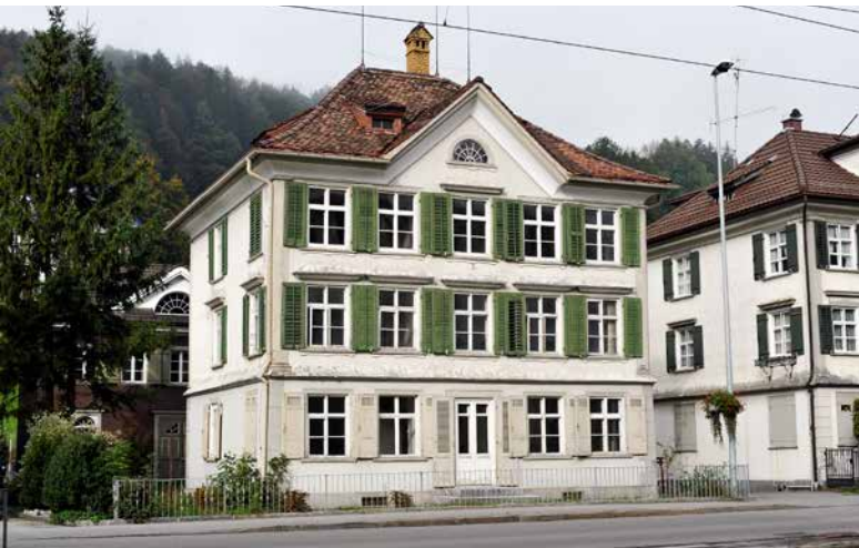
Dorfstrasse 82 in Bühler: Schrägansicht vor der Sanierung. Foto: bm architekten eth sia
