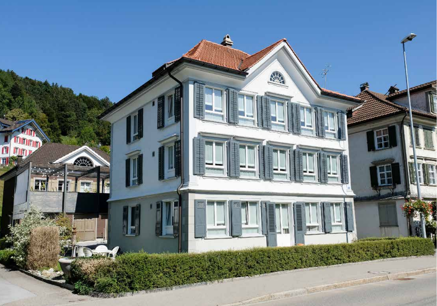
Das alte Haus in neuem Glanz und mit modernen inneren Werten. Foto: D. Steiner
