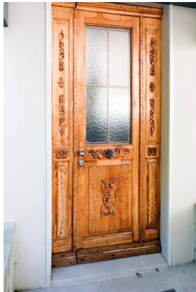
Ein schöner Empfang. Die Eingangstüre wurde mit grossem Aufwand restauriert.
