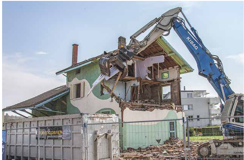
Im alten Bahnhof hatte sich die Jugend einquartiert. Für die Neugestaltung des gesamten Areals kam der Abrissbagger. Foto: M. Reichling, ixedi.ch FOTOGRAFIE
