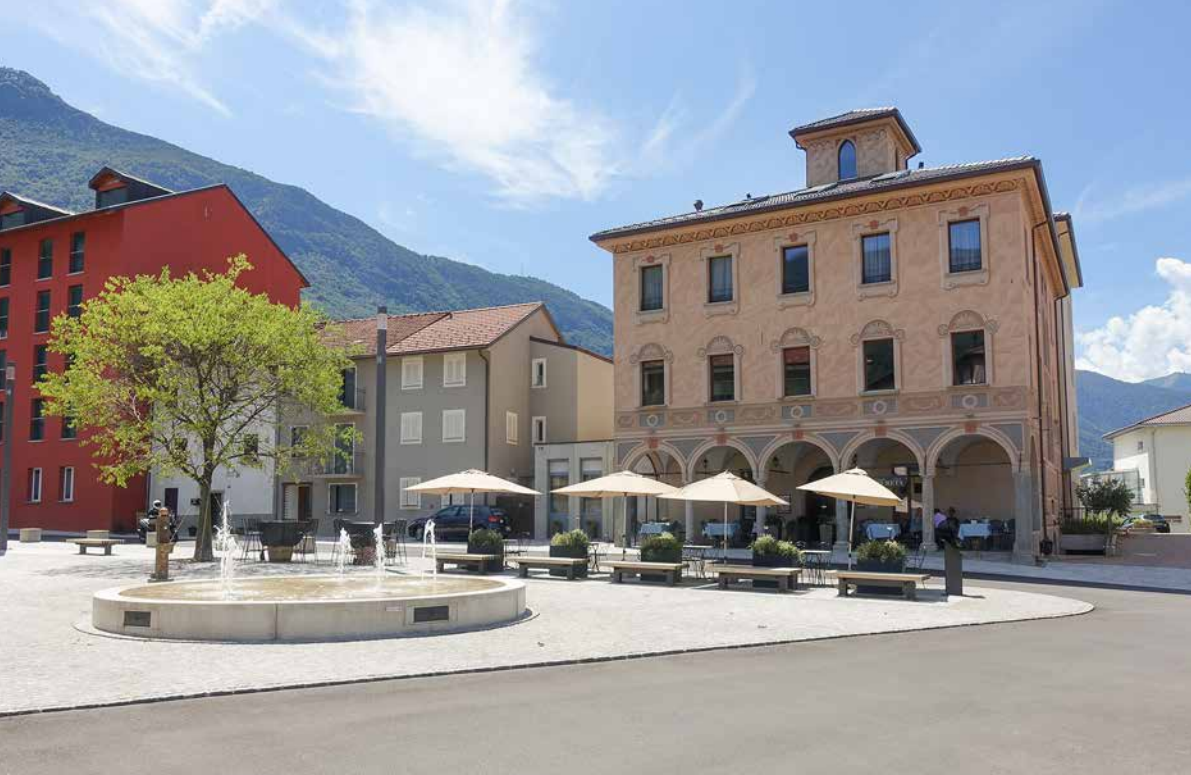
Im Palazzo Scalabrini, einem der grösseren Gebäude an der Piazza Grande, befindet sich das Hotel La Tureta. Die Piazza und das Haus werten sich gegenseitig auf. Foto: A. Beuret, EspaceSuisse
