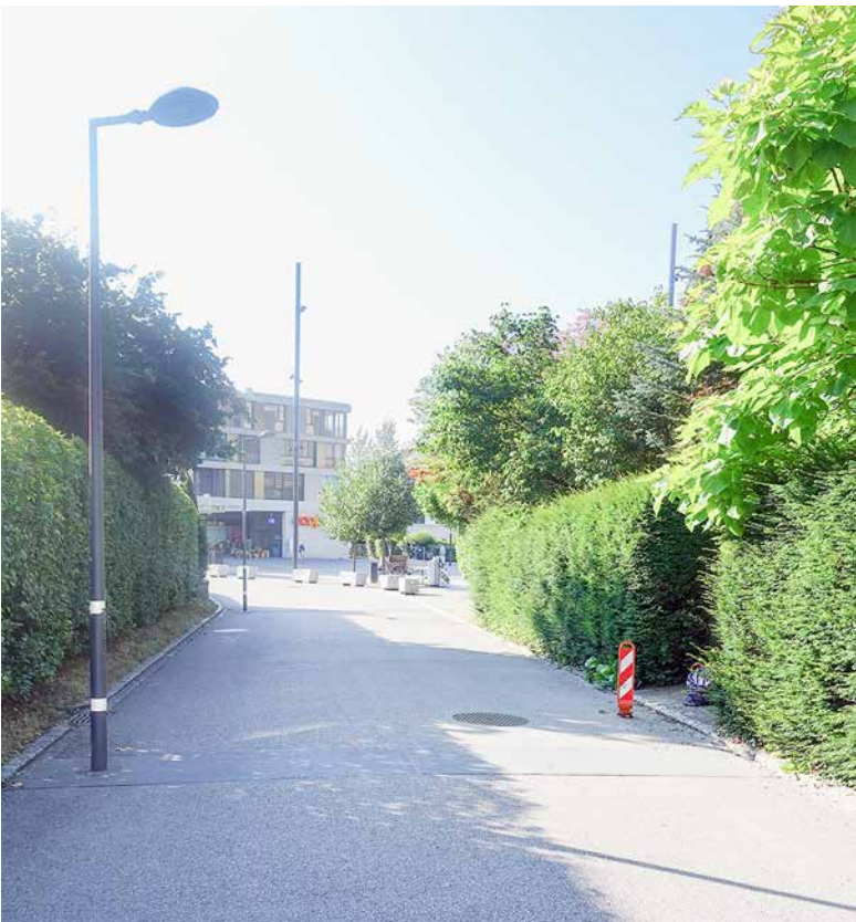
Die Dorfstrasse führt vom Norden her zum neuen Dorfplatz und ist Teil der Begegnungszone mit Tempo 20.
