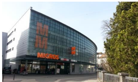
Figure 30. Centre commercial entre le secteur gare et la vieille ville, Delémont.
