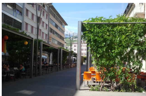
Figure 18. Terrasses végétalisées sur la rue des Remparts, Sion.
