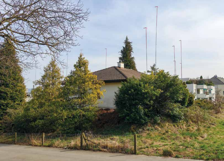
Une autre façon de densifier: les gabarits ne fleurissent pas uniquement en pleine nature, mais aussi autour de constructions anciennes pouvant faire l'objet de densification. Photo: Monika Zumbrunn, EspaceSuisse
