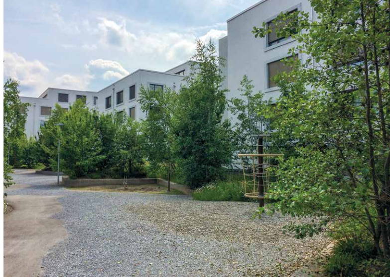
Densité ne rime pas avec désert de béton. Sur densipedia.ch, on trouve de nombreux exemples qui prouvent qu'un développement vers l'intérieur de qualité est possible. Le quartier Fehlmannmatte à Windisch AG, par exemple, fait la part belle aux espaces libres et verts. Photo: Heidi Haag, EspaceSuisse
