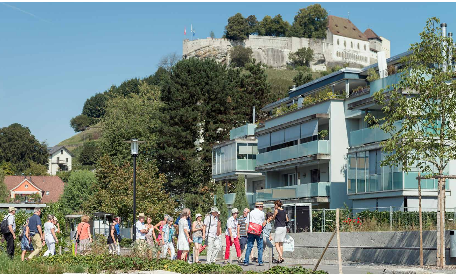
Une culture du bâti de qualité crée des quartiers animés et diversifiés, comme ici en ville de Fribourg. Toutes les photos: Timo Ullmann, NIKE.
