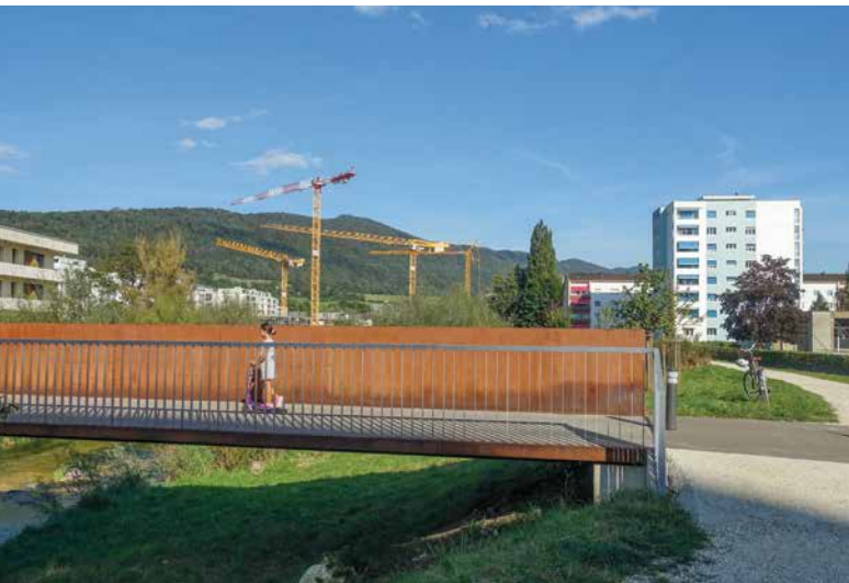
L'écoquartier est en chantier derrière la passerelle.
