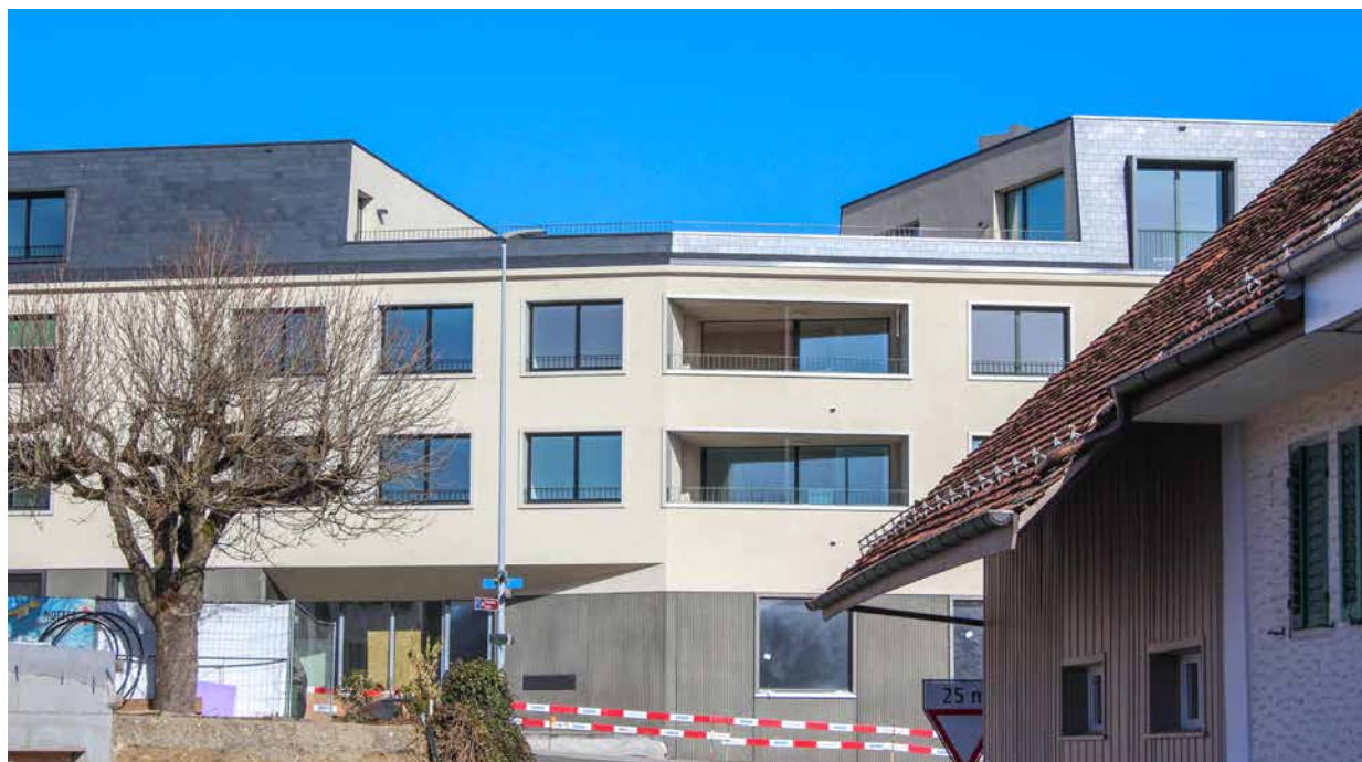
Les habitants craignaient que la hauteur des nouveaux bâtiments de la Mellingerstrasse favorise la propagation du bruit par réflexion. La solution: la partie médiane du bâtiment a un niveau de moins, et son toit sert de terrasse aux appartements situés à droite et à gauche. L'investisseur a perdu un logement, mais en échange, il a pu en valoriser deux. Photo: Remy Rieder, EspaceSuisse
