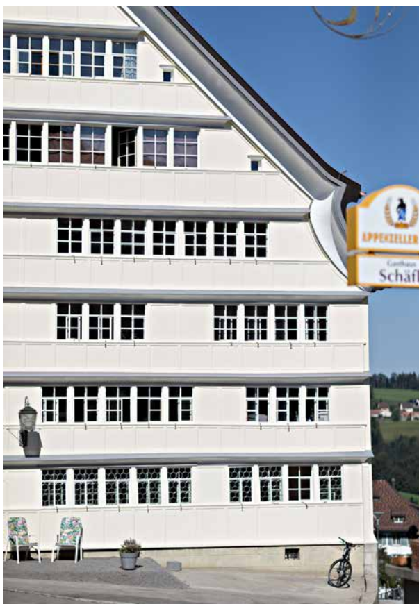
À la campagne, les coopératives d'habitation entrent en jeu surtout lorsqu'il y a pénurie, de logements pour personnes âgées, par exemple. L'ancienne droguerie de Trogen AR est aujourd'hui une maison intergénérationnelle. Photo: Michele Limina
