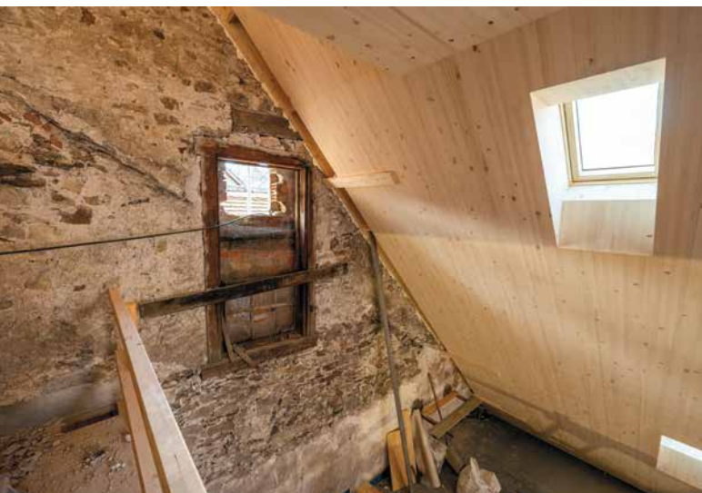
La substance bâtie historique permet d'y aménager des logements avec beaucoup de cachet. Les trois ateliers situés sous le toit ont été terminés au printemps 2023.
