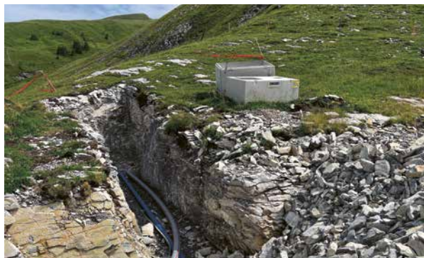
Dispositif d'enneigement artificiel en construction.
